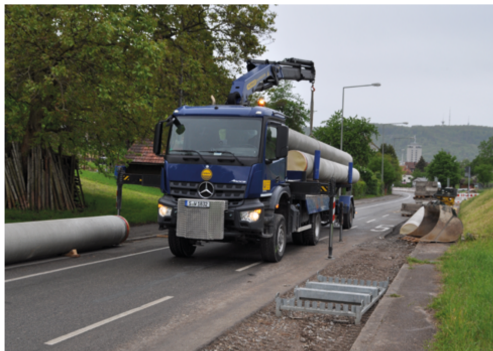
Transport der Wasserrohre DN 700.
