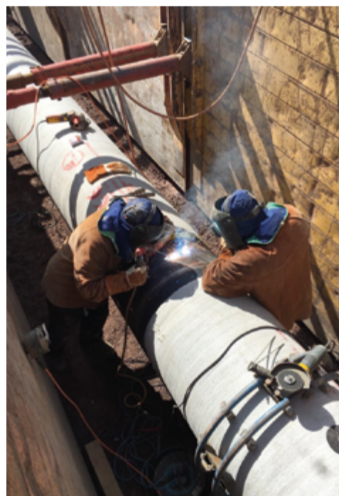
Schweißarbeiten an der Wasserleitung DN 700.
