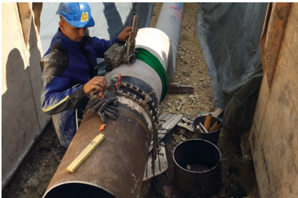
Umlegung einer Gashochdruckleitung DN 400.
