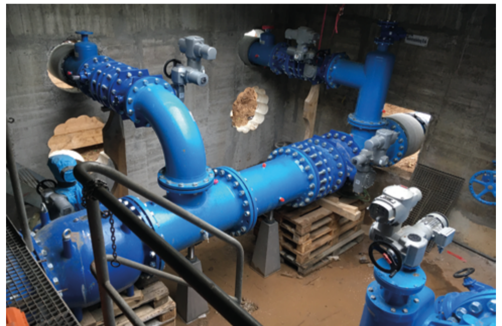
Erneuerung der Armaturen und Formstücke DN 500 und DN 700 im Schacht Bikenstraße.
