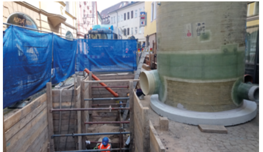
Die Baugrube mit dem waagerechten Holzverbau ist vorbereitet. Nun kann der GFK-Schacht DN 1800 mit dem Zu- und Ablauf der Nennweite DN 600 und dem seitlichen Zulauf DN 300 eingesetzt werden.
