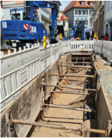
Die Teilverfüllung des Rohrgrabens erfolgt mit Flüssigboden der Konsistenz kf. Der zeitweise fließfähige Verfüllbaustoff verdichtet sich von selbst. Auf diese Weise entstehen keine Erschütterungen durch entsprechende Geräte.
