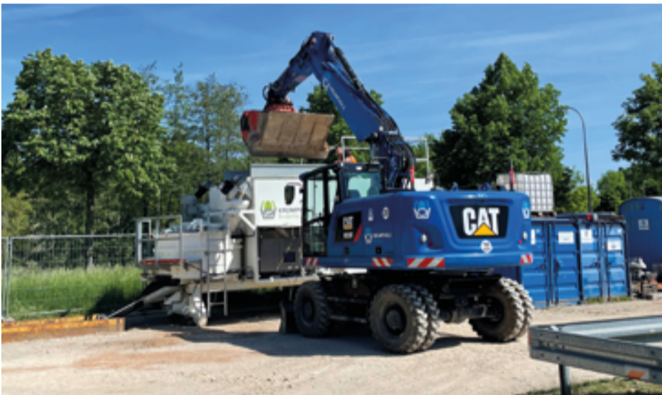
Bei den verschiedenen Maßnahmen in Ansbach kommt Flüssigboden zur Verfüllung der Leitungszonen und zur Rohrgrabenauffüllung zum Einsatz. In der Mischanlage wird die Rezeptur je nach Bodenbeschaffenheit und Einsatzzweck angepasst.
