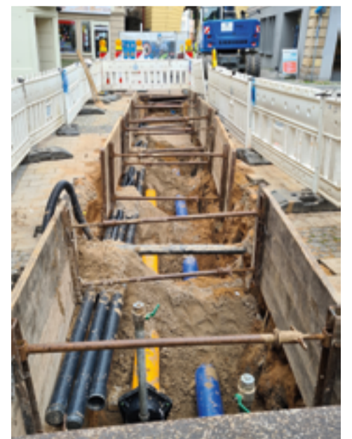
Um die Rohrstränge nach dem Verlegen zu fixieren, setzte die Karl Krumpholz Rohrbau GmbH Flüssigboden der Konsistenz kp ein.
