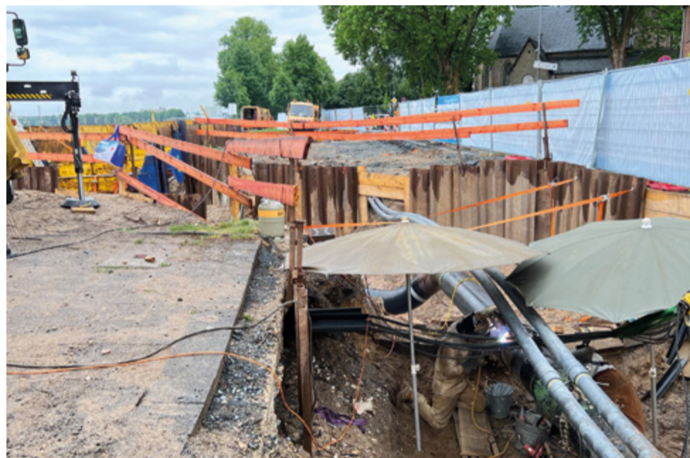
Gerade bei Gashochdruckleitungen sind einwandfrei hergestellte Schweißnähte von entscheidender Bedeutung. Am Niehler Damm wandten Schweißer von der RN Rohrleitungsbau Niederrhein das anspruchsvolle Fallnahtschweißen mit zelluloseumhüllten Stabelektroden CEL 90 an. (Foto: RN Rohrleitungsbau Niederrhein GmbH)
