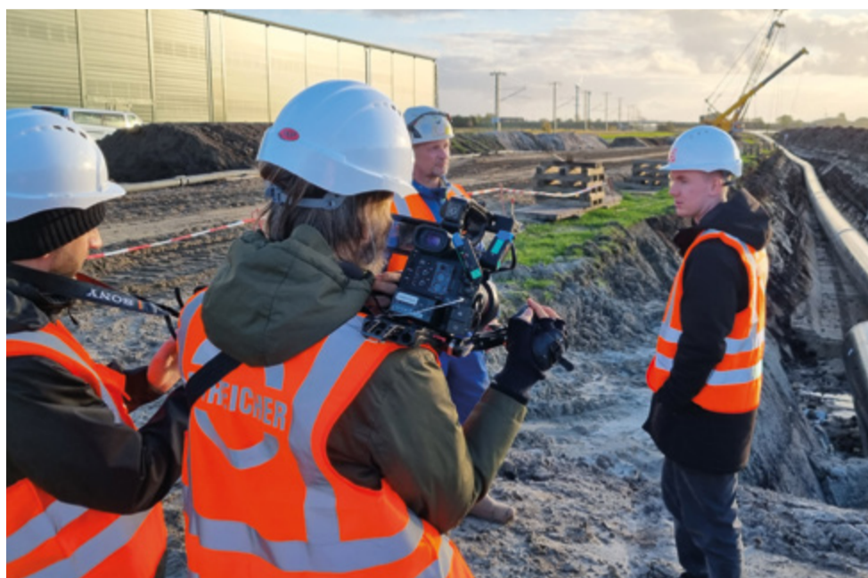
Impressionen vom Bau der WAL: Der YouTuber tomatolix hat die Leitungsbauer einen Tag auf der Baustelle begleitet. (Fotos: rbv)
