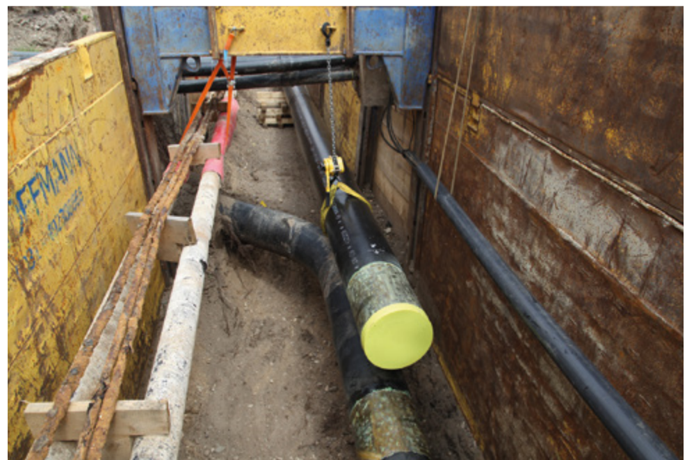
Die Vorbereitungen sind getroffen. Für das Einbinden der neuen Gashochdruckleitung herrschte ein strikter Zeitplan. Zuerst mussten die angeschlossenen Kraftwerke außer Betrieb gehen. (Foto: rbv)
