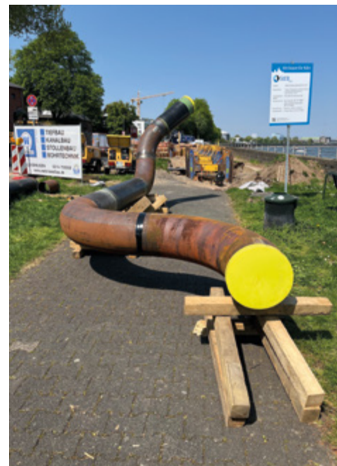
Der vorgefertigte Rohrstrang der neuen Gashochdruckleitung liegt bereit für den Einbau. (Foto: RN Rohrleitungsbau Niederrhein GmbH)
