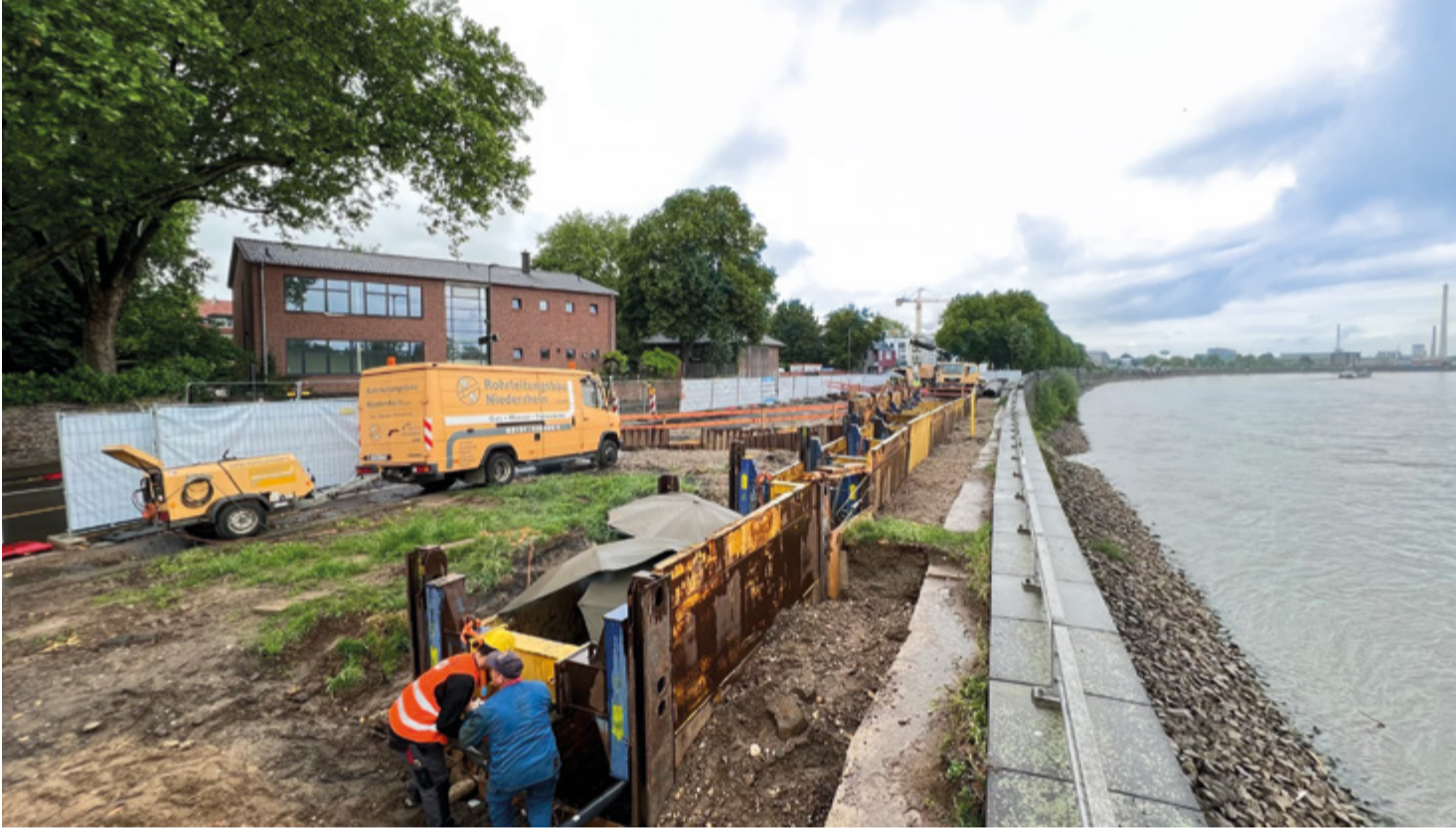
Am Niehler Damm befindet sich die Anschlussstelle des Rheindükers, der einen Großteil der Abwässer aus dem linksrheinischen Köln zum Klärwerk nach Stammheim transportiert. Hier soll ein neuer Rheindüker mittels Pipe-Jacking-Verfahren errichtet werden. Im Zuge der Vorbereitungsmaßnahmen für den Zielschacht wurde die RN Rohrleitungsbau Niederrhein GmbH von der RheinEnergie mit der Umlegung einer Gashochdruckleitung beauftragt. (Foto: RN Rohrleitungsbau Niederrhein GmbH)
