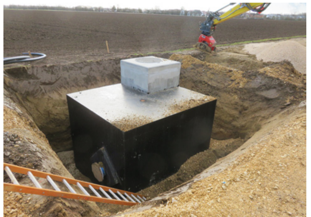
Die Baugrube ist mit dem digitalen Baugrubenassistenten hergestellt worden. Mit seiner Hilfe lassen sich die Größe der Grube, der Aushub und der Böschungswinkel berechnen. So entsteht weniger Aushub und Lkw-Fahrten werden reduziert.
