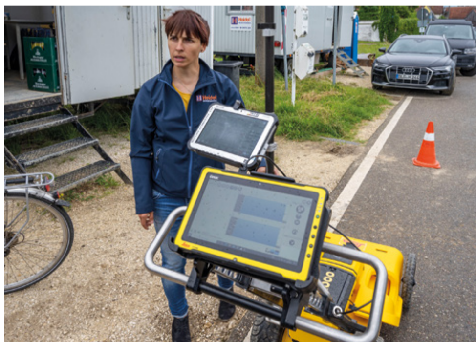
Die Fremdsparten werden mit dem Bodenradar geortet und in die digitale Planung übertragen.
