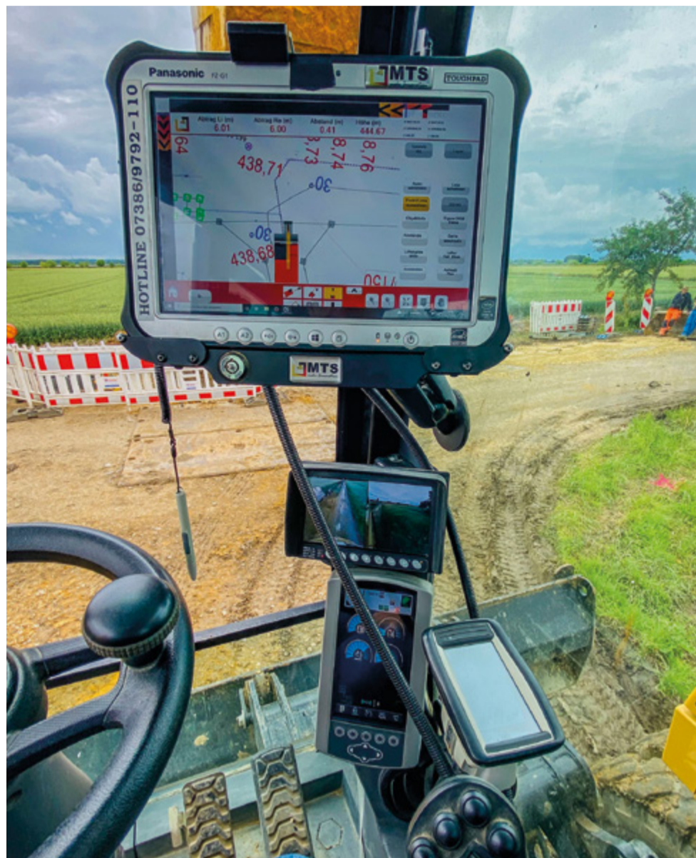
Das Tablet zeigt dem Baggerfahrer alle digitalen Daten an, die für die Baumaßnahme erforderlich sind. Dadurch entfällt das Handaufmaß. (Fotos: Rohrleitungsbau Fritz Heidel OHG)
