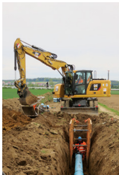
Die Baustelle wird mit der Baggersteuerung ausgeführt. Da der Ausführungsplan vom Ingenieurbüro Kapfer schon in 3-D gezeichnet worden war, musste vor Baustellenbeginn nur noch die Datenaufbereitung vorgenommen werden.
