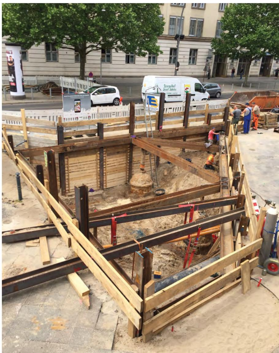
Baugrube Schieberkreuz – im Zuge des zweiten Bauabschnitts hat Echterhoff das hier vorhandene Schieberkreuz bestehend aus Leitungen DN 900 GG und drei Schiebern durch ein Schieberkreuz DN 1000 St beziehungsweise DN 800 St sowie eine Klappe DN 1000 und zwei Klappen DN 800 mit zugehörigen Pass- und Ausbaustücken ersetzt.
