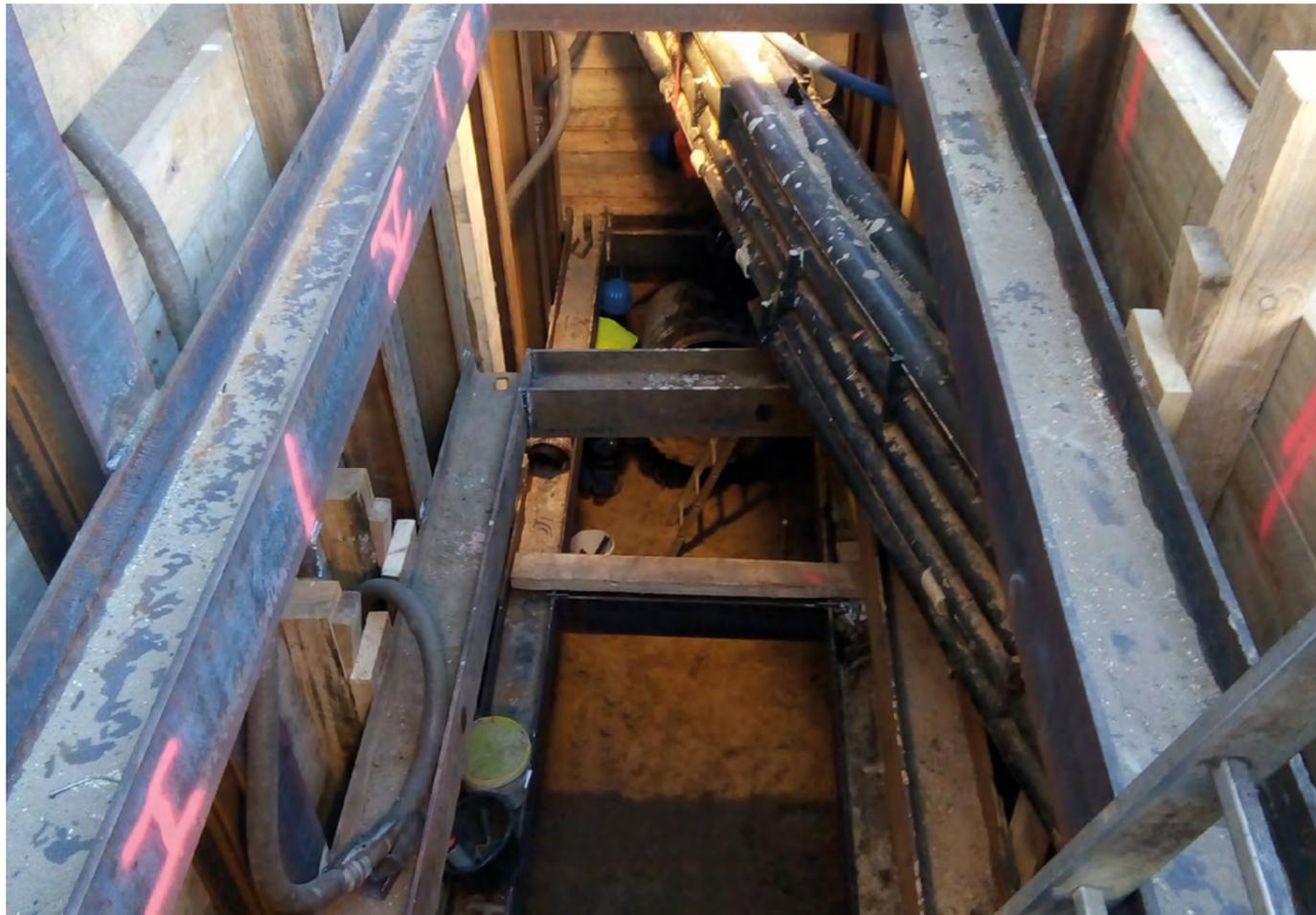
Die Erstellung der Baugrube in der Grunewaldstraße war einer der sensibelsten Meilensteine der gesamten Baumaßnahme. Die Baugrubensicherung erfolgte über einen mit Stahlträgern ausgesteiften Berliner Verbau. (Fotos: Echterhoff)
