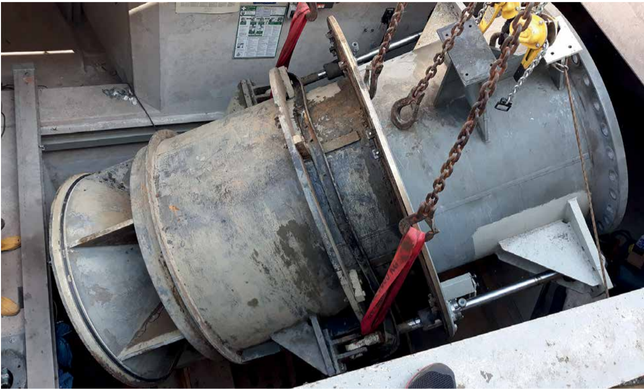
Für die Demontearbeiten stand nicht viel Platz zur Verfügung: Erst nach dem Ausbau der Abdeckplatte und des Zwischenbodens im Antriebsraum sowie der Demontage des Hydraulikantriebes konnte der Kegelstrahlschieber demontiert werden. (Foto: CTR)
