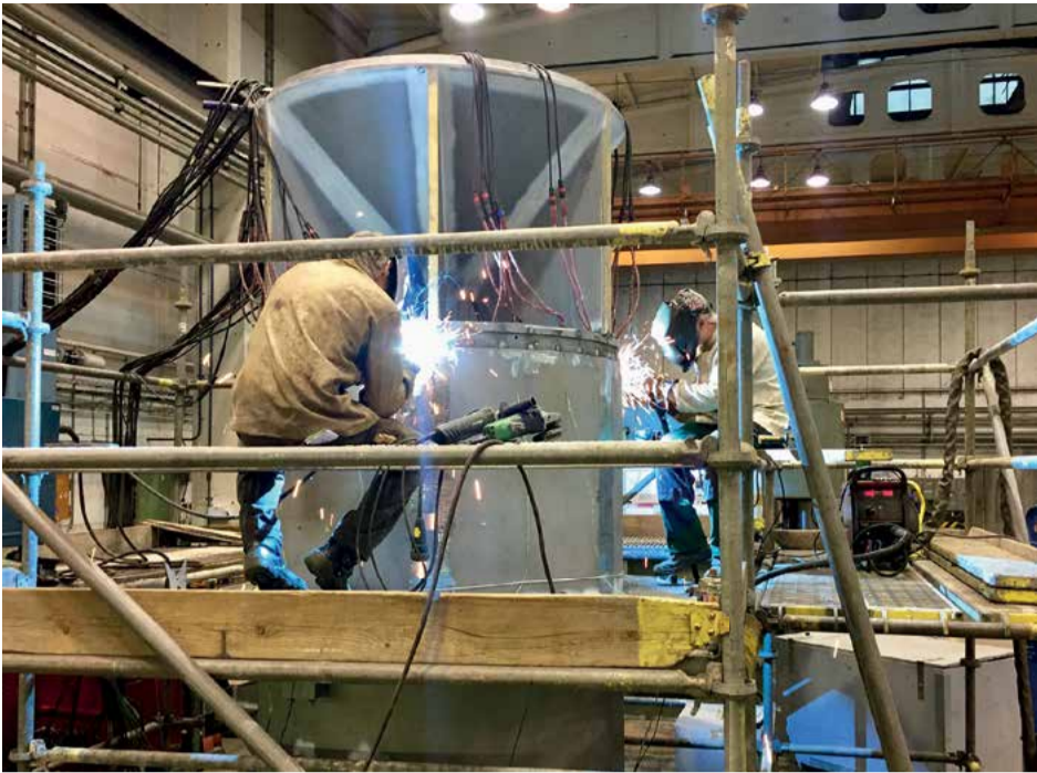
Die Kavitationsschäden wurden durch mehrlagige Auftragsschweißungen fachgerecht beseitigt. (Foto: RAC)
