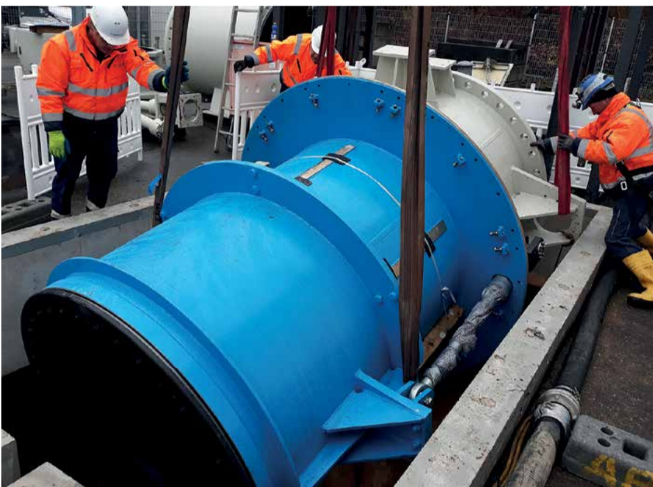
Auch bei dem Wiedereinbau war Millimeterarbeit gefragt: Der instandgesetzte Kegelstrahlschieber wurde langsam abgelassen. (Foto: CTR)
