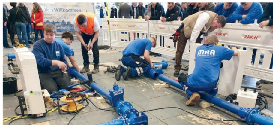
Aufgabe im Rahmen der Rohrleitungsbau-Challenge war die fachgerechte Herstellung einer simulierten Trinkwasserleitung DN 100/80. (Foto: rbv)
