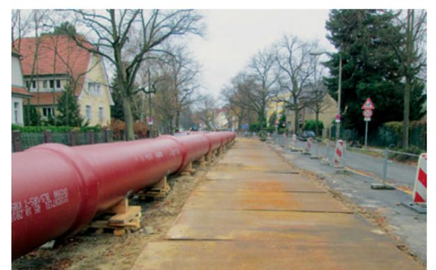
Rohrstrang mit Auflagern und ausgelegten Stahlplatten.
