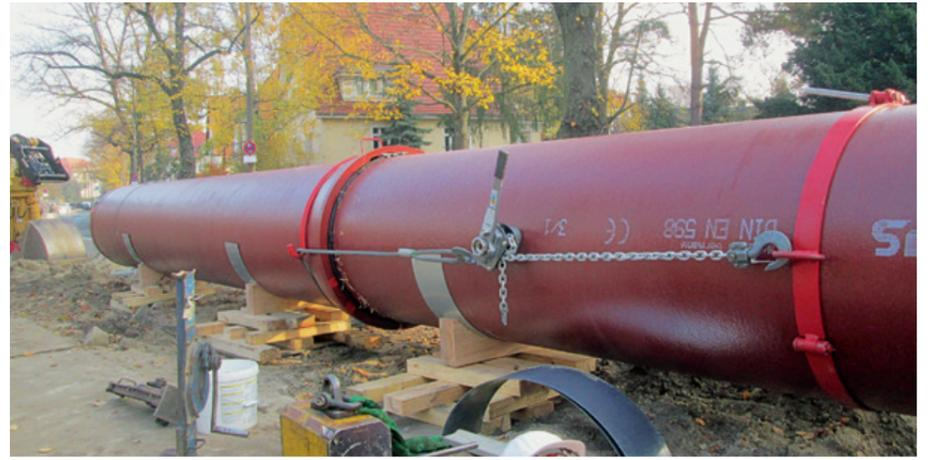
Montierte BLS®-Verbindung mit Rohrauflegern.
