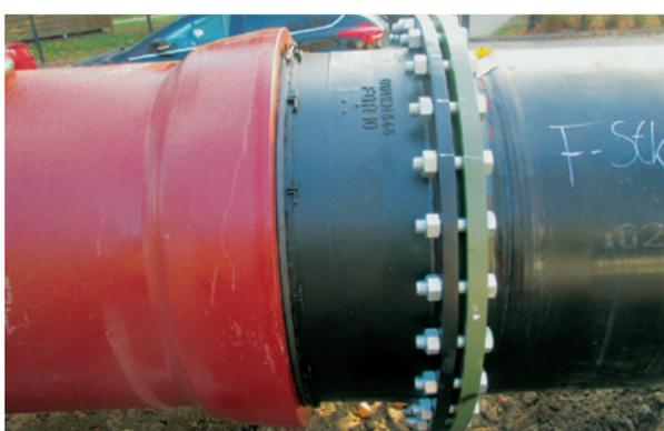
In die Rohrmuffe montiertes F-Stück mittels BLS®-System.
