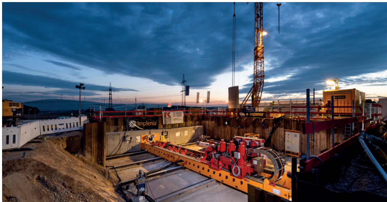
Startbaugrube mit eingebauter Vortriebsanlage.
