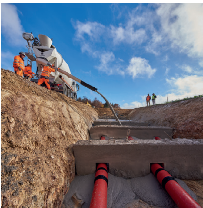
Einbau des Flüssigbodens mit Fahrmischer. (Foto: Franz KASSECKER GmbH)
