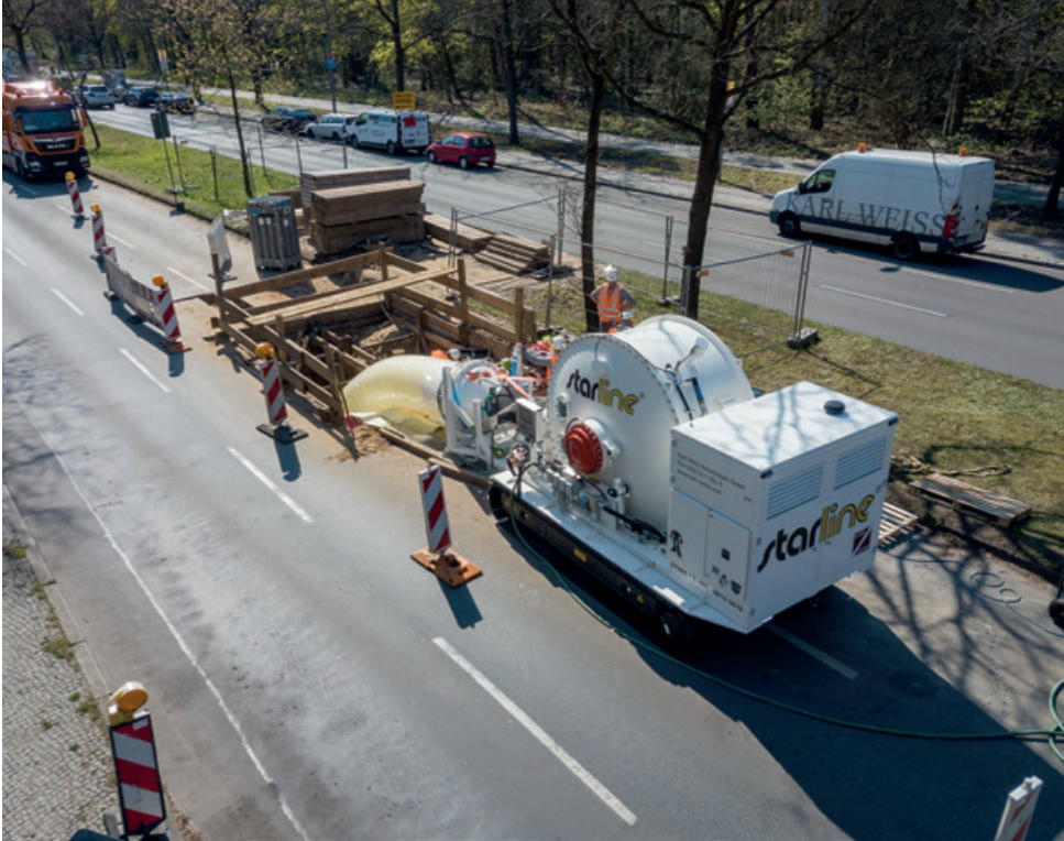
Um das bewährte und erforderliche Qualitätsniveau grabenloser Technologien für die Sanierung, Erneuerung und Neulegung auch zukünftig abzusichern, wurde der Arbeitskreis „Grabenlose Bauweisen für Rehabilitation und Neulegung von Leitungssystemen“ reaktiviert. (Foto: Karl Weiss Technologies GmbH)
