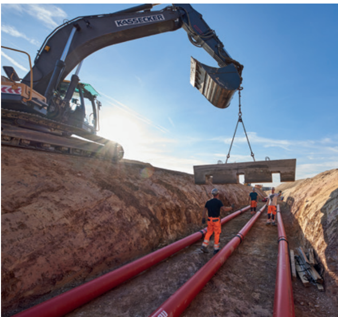
Versetzen der Auftriebssicherungen über den vorgestreckten Rohrstrang. (Foto: Franz KASSECKER GmbH)
