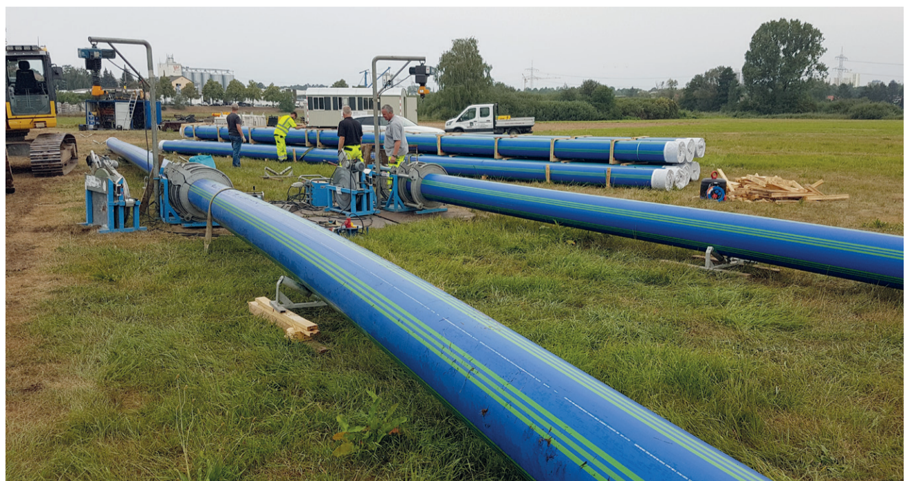
Für die einzuziehenden Rohrstränge wurde eine maximale Länge von 250 Metern ermittelt. Für den über rund 700 Meter geplanten Einzug wurden drei Rohrstränge ausgelegt und die einzelnen Rohre mittels Spiegelschweißung miteinander verbunden.
