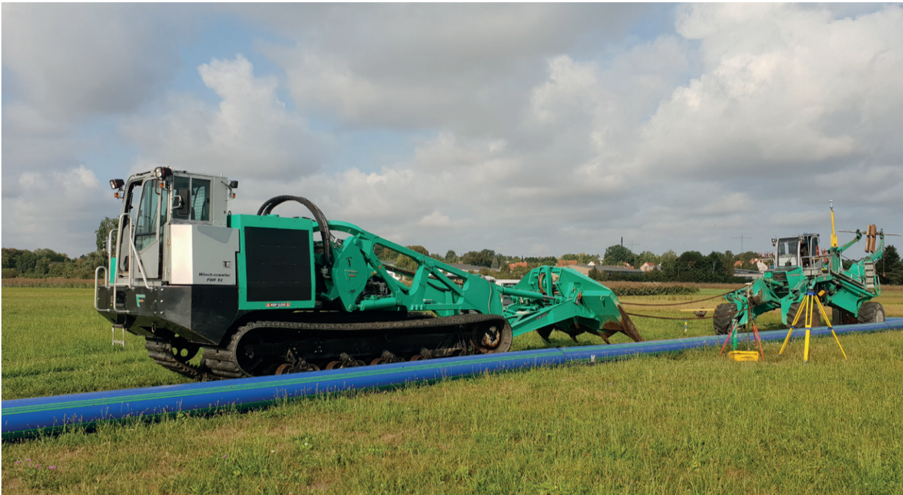
In Erlangen wurde im August 2018 im Zuge der Erweiterung des Trinkwasserversorgungsnetzes erstmalig in Deutschland eine Wasserleitung der Dimension DA 450 im Pflugverfahren verlegt. (Fotos: Rotec Rohrtechnik GmbH)
