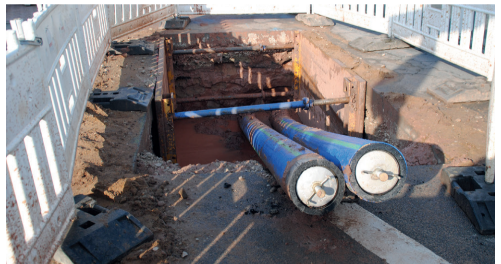
Im Rahmen des zweiten Bauabschnitts „Talquerung Herzogenaauracher Damm“ wurden unter der Regnitz 120 Meter PE DA 225 als Doppelleitung eingebracht.
