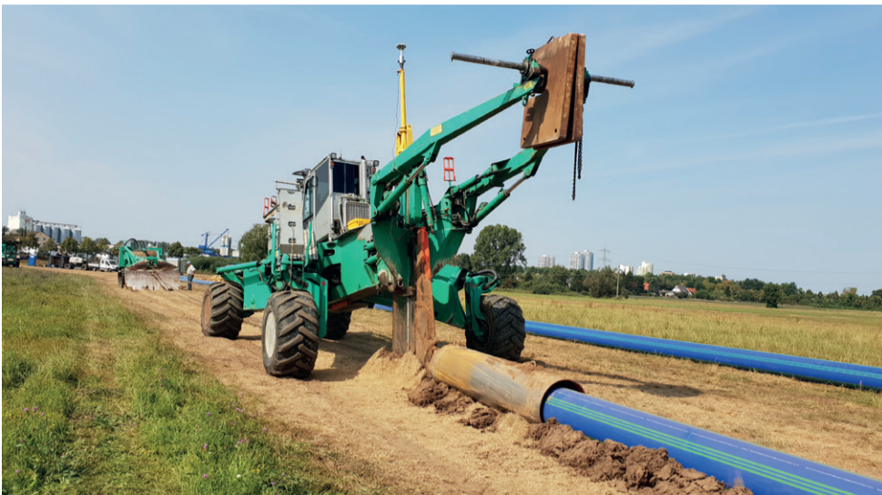
Der bereits vormontierte Rohrstrang wird beim Torpedopflugverfahren direkt an das Verdrängerteil montiert und in den damit geschaffenen Hohlraum eingezogen.
