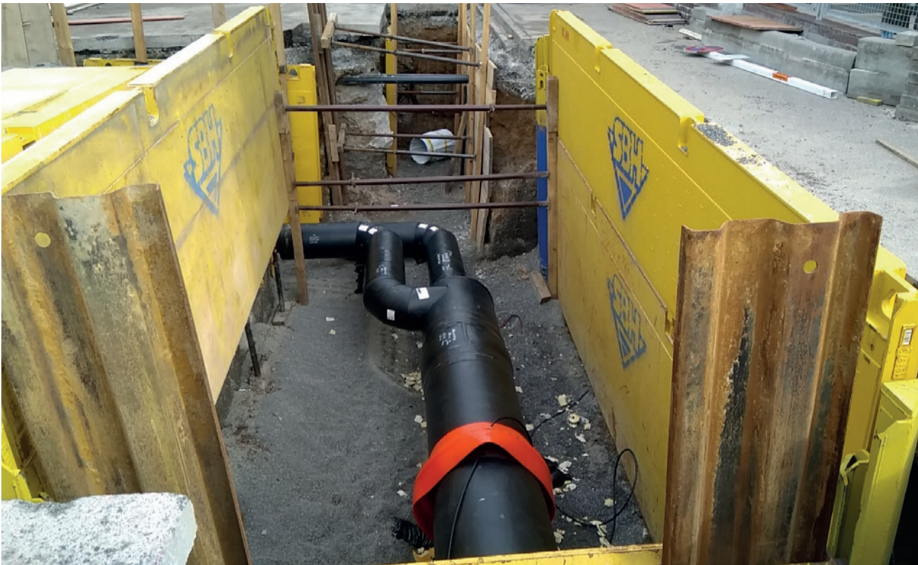
Ein asymmetrisches „Hosenstück“ als Sonderformteil.
