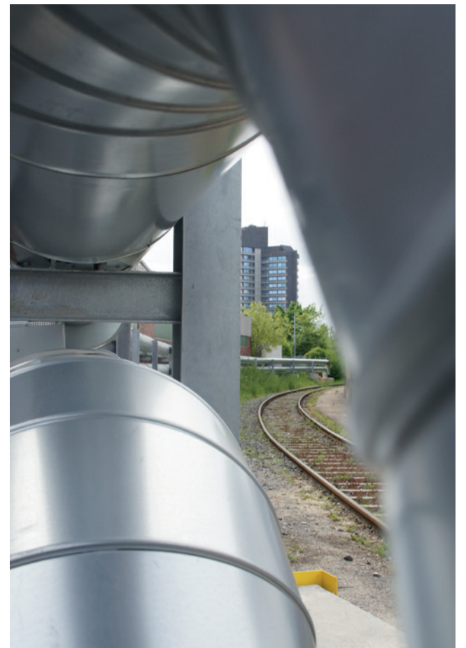
Ein Teil der neu zu erstellenden Fernwärmeleitung wurde parallel zu einer Industriebahnlinie aus dem Boden herausgeführt, aufgeständert, gesichert und mit Metallmantel isoliert. Die für dieses neben der Gleisanlage oberirdisch verlaufende Teilstück erforderlichen Bettungs- und Betonfundamentarbeiten wurden von der Schenek Tiefbau GmbH durchgeführt. (Foto: Stadtwerke Ludwigsburg-Kornwestheim GmbH, SWLB)
