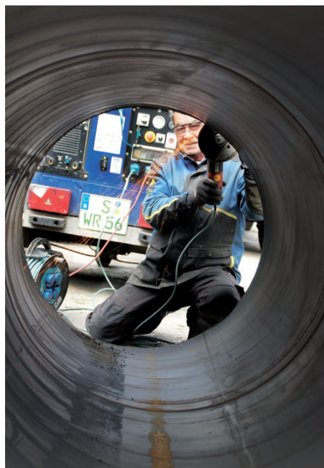
Das „Anfasen“: Der Monteur beim Schleifen und Vorbereiten eines Rohrendes für die Schweißnaht. (Foto: Stadtwerke Ludwigsburg-Kornwestheim GmbH, SWLB)
