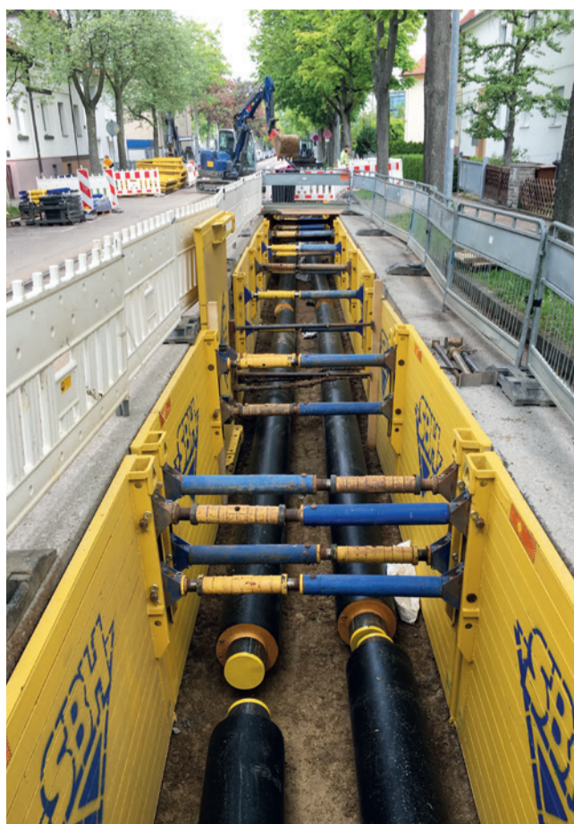
In Ludwigsburg sind für die Erweiterung des Fernwärmeverbundnetzes der SWLB Kunststoffmantelrohre, sogenannte KMR-Rohre, einfach verstärkt, DN 250/DA 450, zum Einsatz gekommen. (Foto: Schenek Tiefbau GmbH)
