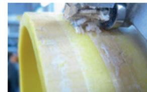
Bei den von der Anomalie betroffenen Rohren reicht ein einmaliges Schälen i. d. R. nicht aus, um eine den Normanforderungen entsprechende Schweißverbindung herzustellen. (Foto: dvgw)
