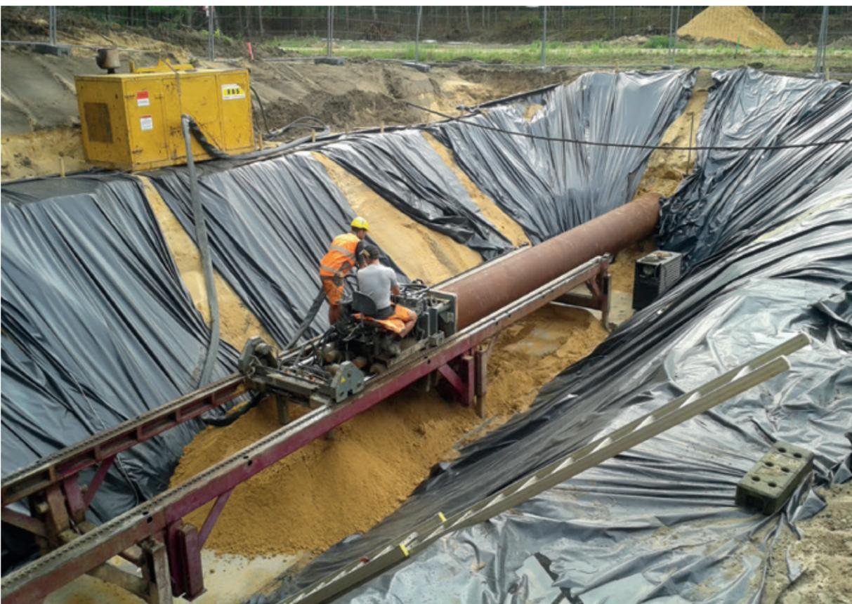
Microtunneling DN 800 zur Querung der B 156.
