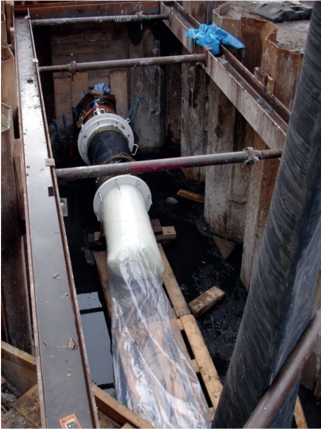
Ankunft eines Gewebeschlaches in der Zielbaugrube. (Foto: Andreas Hüttemann)
