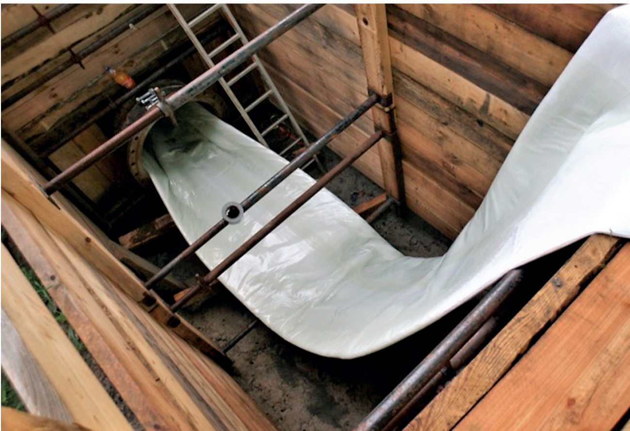
Einzug eines Pull-In-Liners (vor Ort härtendes Schlauch-Lining) in eine Trinkwasserleitung.
