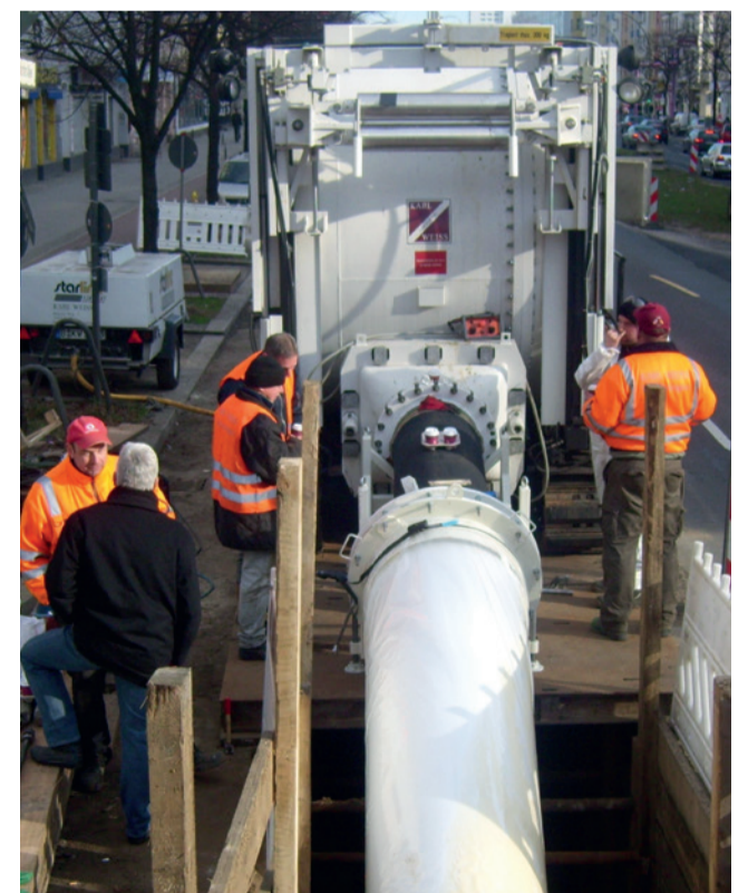
Drucktrommel für das Einbringen eines Gewebeschlauches (Schlauch-Lining mit rückseitiger Verklebung). (Foto: Karl Weiss Technologies GmbH)
