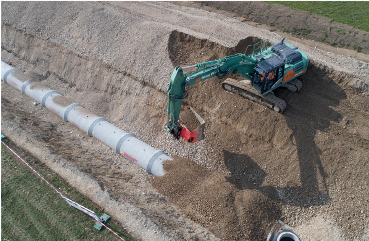
Im ersten Bauabschnitt realisierte die Max Wild GmbH die Rohrtrasse zwischen der Autobahn 7 und dem Ortsrand von Kirchdorf an der Iller. In offener Bauweise verlegten die Tiefbauspezialisten mit bis zu 40 t schweren Baggern die Stahlbetonrohre DN 1400. (Fotos: Max Wild GmbH)
