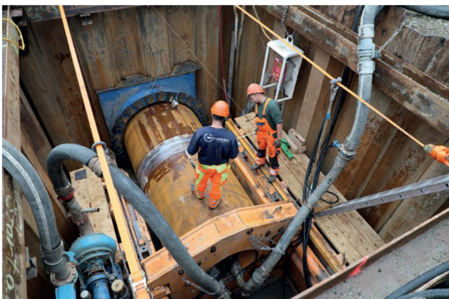
Im Bereich der Autobahn werden die Vortriebsmaschine und die Stahlbetonrohre von der Startgrube aus mit Hydraulikzylindern in den Untergrund gepresst.
