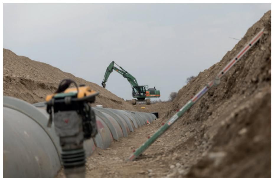
In einer Tiefe von bis zu 5 m werden die Stahlbetonrohre verlegt.
