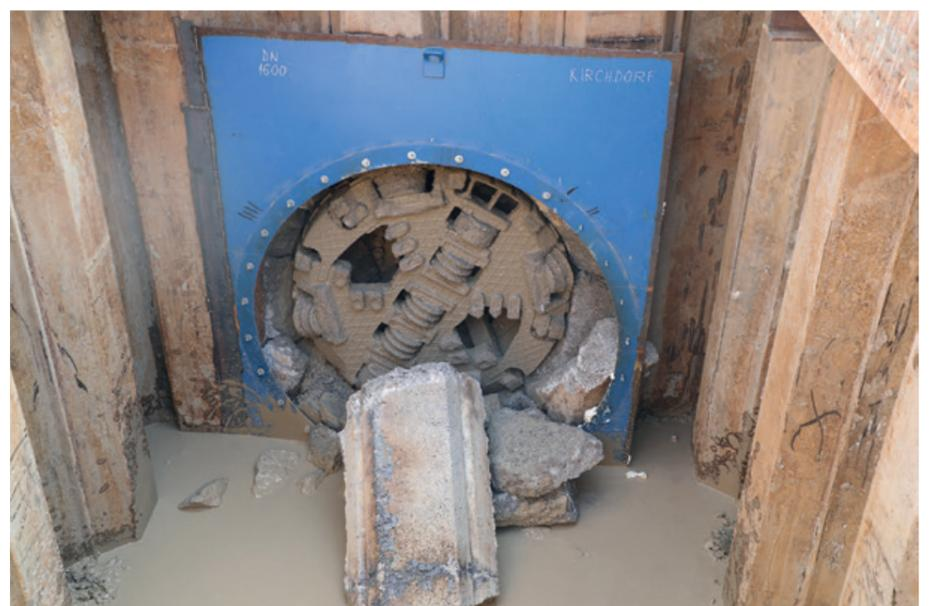
Der 17 t schwere Bohrkopf hat nach rund 60 m die Zielgrube erreicht.
