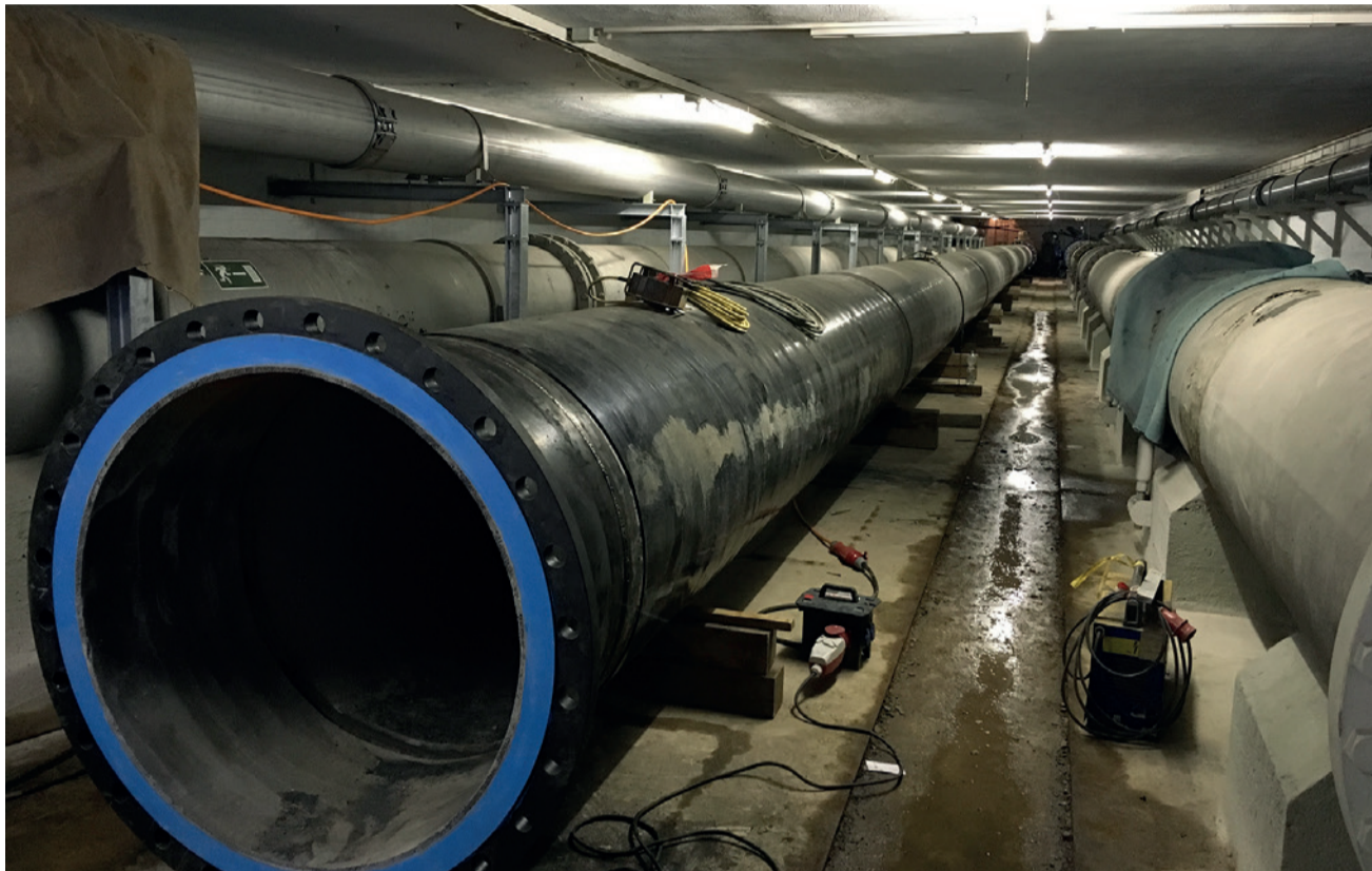
Im Bauabschnitt befinden sich zwei Straßenquerungen: Neben der B 486, die mittels Durchpressung DN 1400 unterquert wird, ist dies die Unterquerung der A 67 in Form des vorhandenen Tunnelbauwerks. Hier wird zur Entlastung der vorhandenen Bestandsleitung die Stahlleitung DN 1000 mit Zementmörtelauskleidung und PE-Außenbeschichtung eingebaut. (Fotos: Markgraf)
