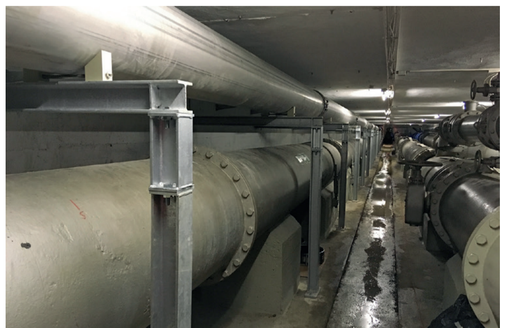
In der 1963/1964 in Spannbetonrohren ausgeführten Riedleitung wird das Trinkwasser von den Wasserwerken im Hessischen Ried in den Ballungsraum Rhein-Main transportiert.
