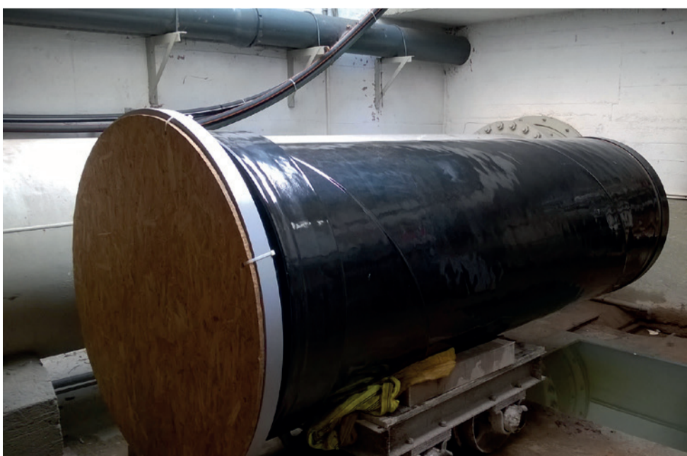
Unter Zuhilfenahme eines eigens für diesen Zweck konstruierten Transportwagens werden die 4 m langen und 1,6 t schweren Rohrstücke zum Einbauort transportiert.
