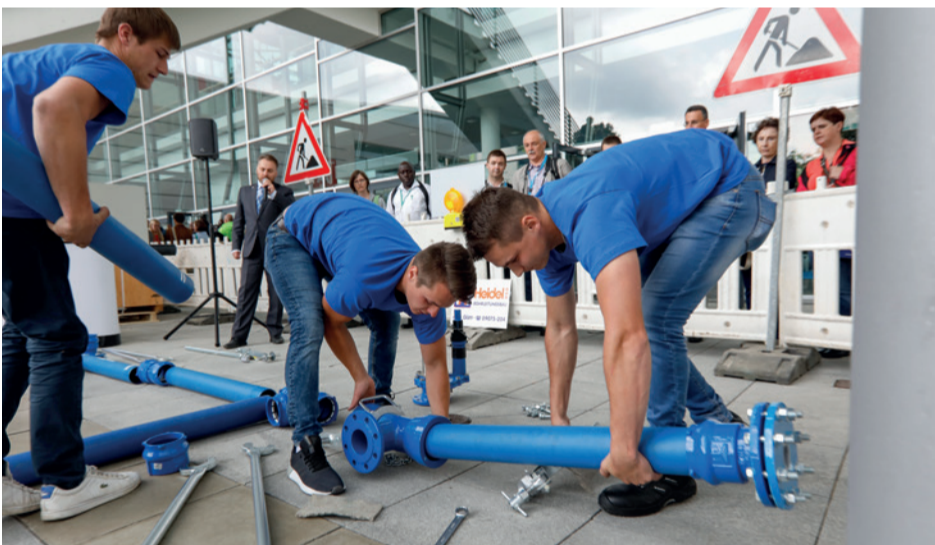
Die Teams der „Leitungsbauchallenge“ stellten ihr Können bei der regelkonformen Umsetzung von Aufgaben aus den Bereichen der Wasserversorgung auf der Aktionsfläche der Messe unter Beweis.
