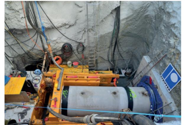
Abschnittsweise werden die Stahlbetonrohre DN 1200 nachgeschoben.
