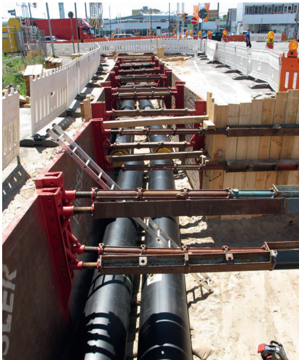
Um Unfälle in den Gräben zu vermeiden, müssen einige Aspekte beachtet werden – zum Beispiel die richtige Sicherung der Wände. (Fotos: BG ETEM, Dirk Ruhland; et al.)
