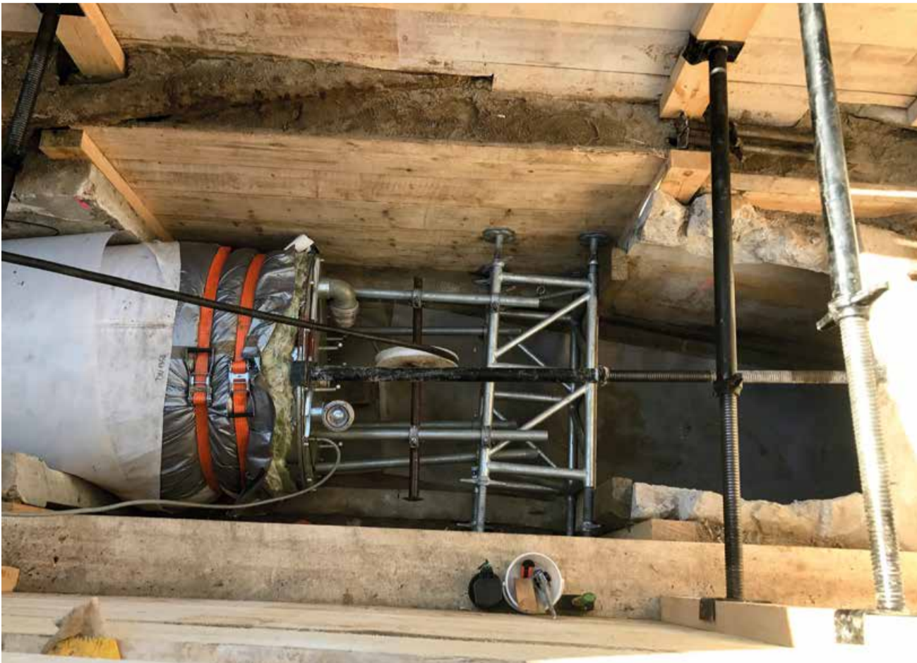
Sanierung eines Kastenprofils in der Sadowastraße, Berlin, mit dem Alphaliner1800. Das spezielle Packerverbau-System von Relineeurope sorgt für die Absicherung gegen den sehr hohen Druck beim Aufstellen des Schlauchliners mit Druckluft. (Fotos: RELINEEUROPE)
