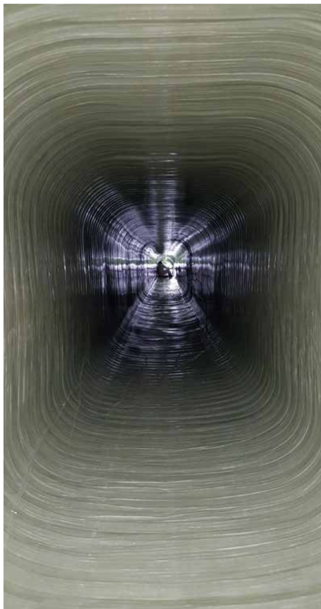
Der sanierte Kanalabschnitt
