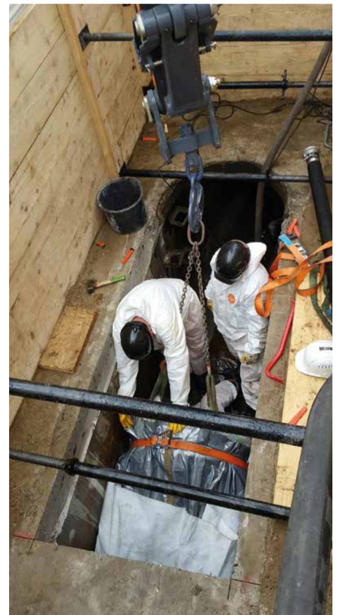
Die Sanierung des Kastenprofils führte die Frisch & Faust Tiefbau GmbH durch.
