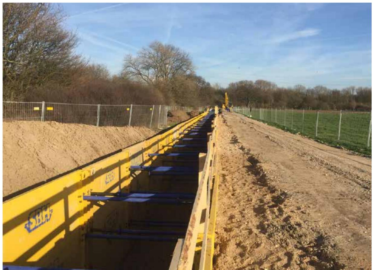
Aufgrund des beengten Baufeldes von ca. 6 m Breite sind verschiedene Anforderungen zu erfüllen. Neben der Sicherung der Baugrube und des Baufeldes betreffen diese unter anderem den Schutz der Natur entlang der Trasse.
