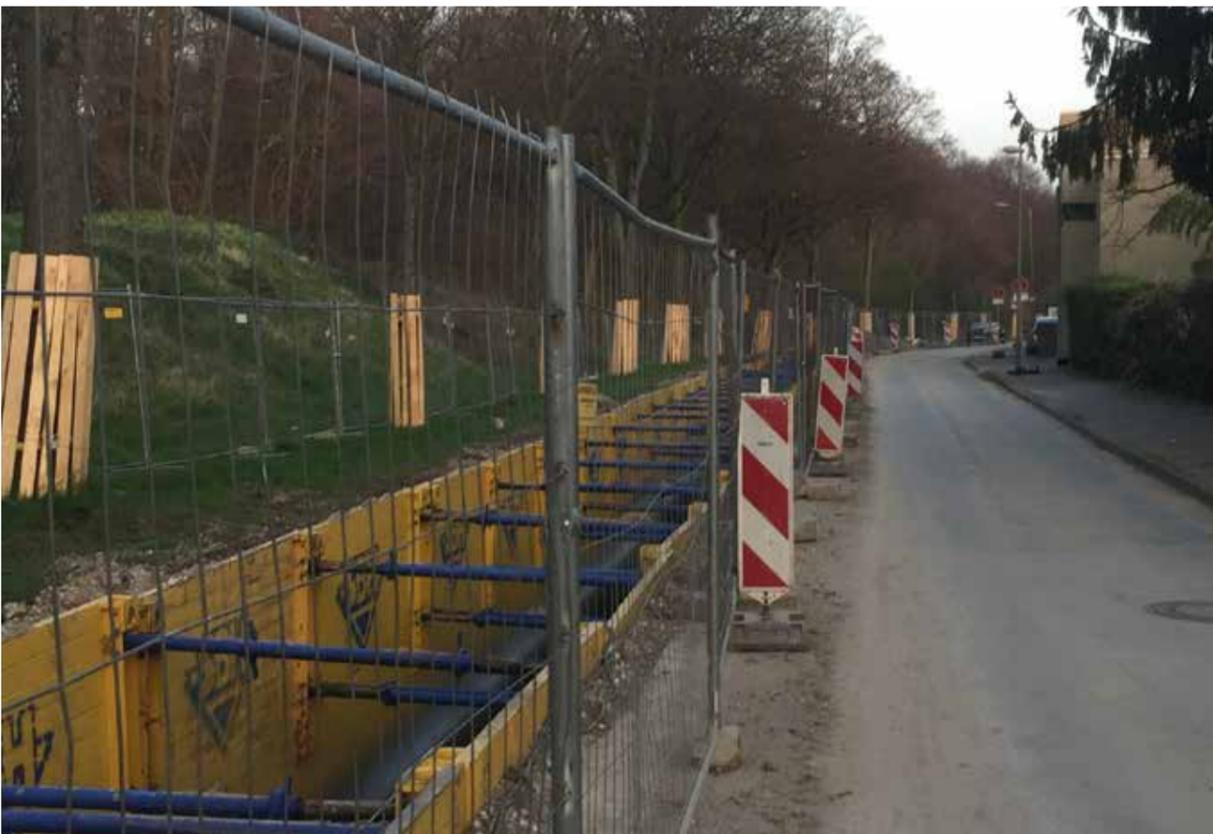
5,8 km lang ist die Fernwärmeleitung, die die Reinhard Rohrbau GmbH, Meppen, im Auftrag der Fernwärmeverbund Duisburg/Dinslaken GmbH & Co. KG, Dinslaken, verlegt. Die Leitung ist Teil der Fernwärmeschiene Niederrhein und transportiert industrielle Abwärme. (Fotos: Reinhard Rohrbau)
