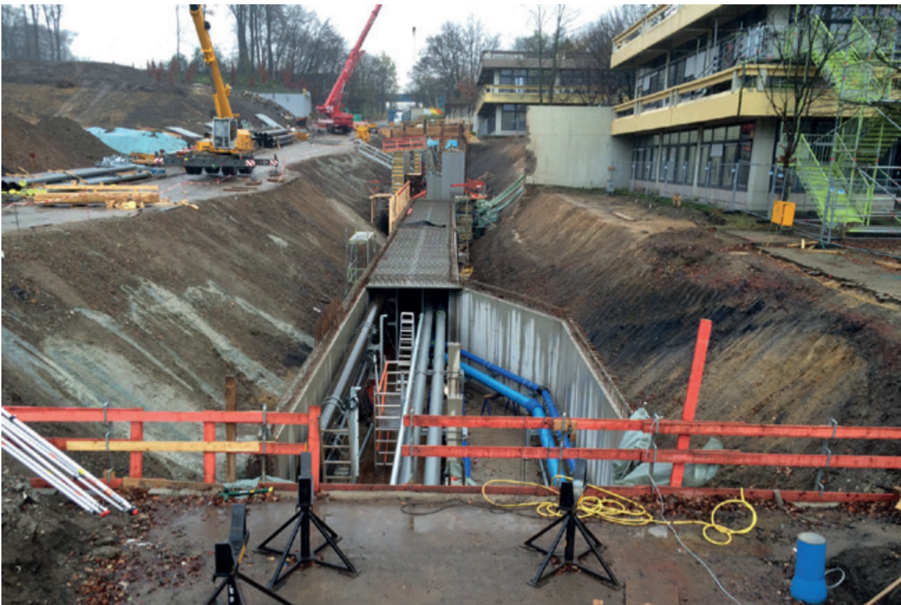
Die Fertigstellung des Medienkanals erfolgte abschnittsweise. Dem Baufortschritt folgend wurden die Rohrleitungen in die noch nicht verschlossenen Bereiche eingebracht. (Fotos: Central Rohrtechnik)
