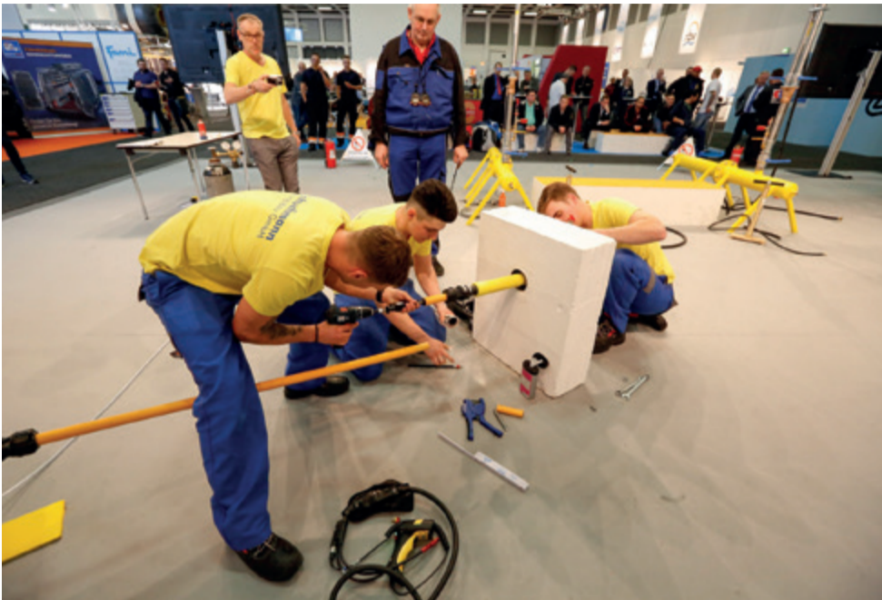
Aufgabe der Teams der Gas-Challenge war es, zunächst eine bestehende Stahl-Gasversorgungsleitung im Betrieb zu verlängern und danach einen Hausanschluss an einer ebenfalls in Betrieb befindlichen Gasversorgungsleitung zu erstellen. (Fotos: Rohrleitungsbauverband)
