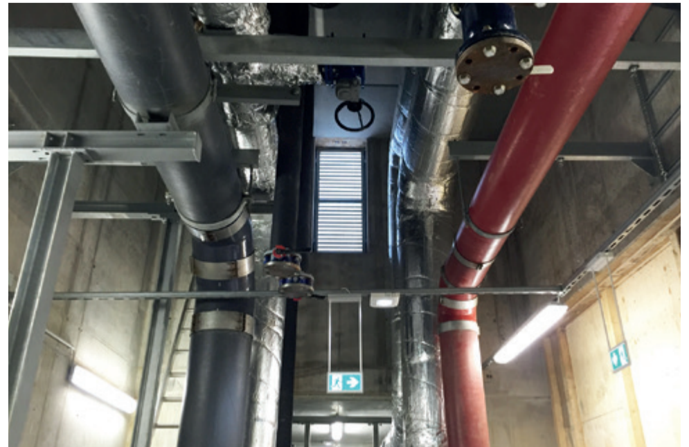
Die Chemiewasserrohrleitung (li.) erhielt eine spezielle Innenbeschichtung und die Trinkwasserleitung daneben eine äußere Umhüllung.
