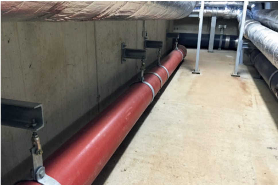
In Bereichen mit größerem Gefälle wurden zum Höhenausgleich Peiner-Träger für die Aufhängung der Abwasserleitung eingesetzt.
