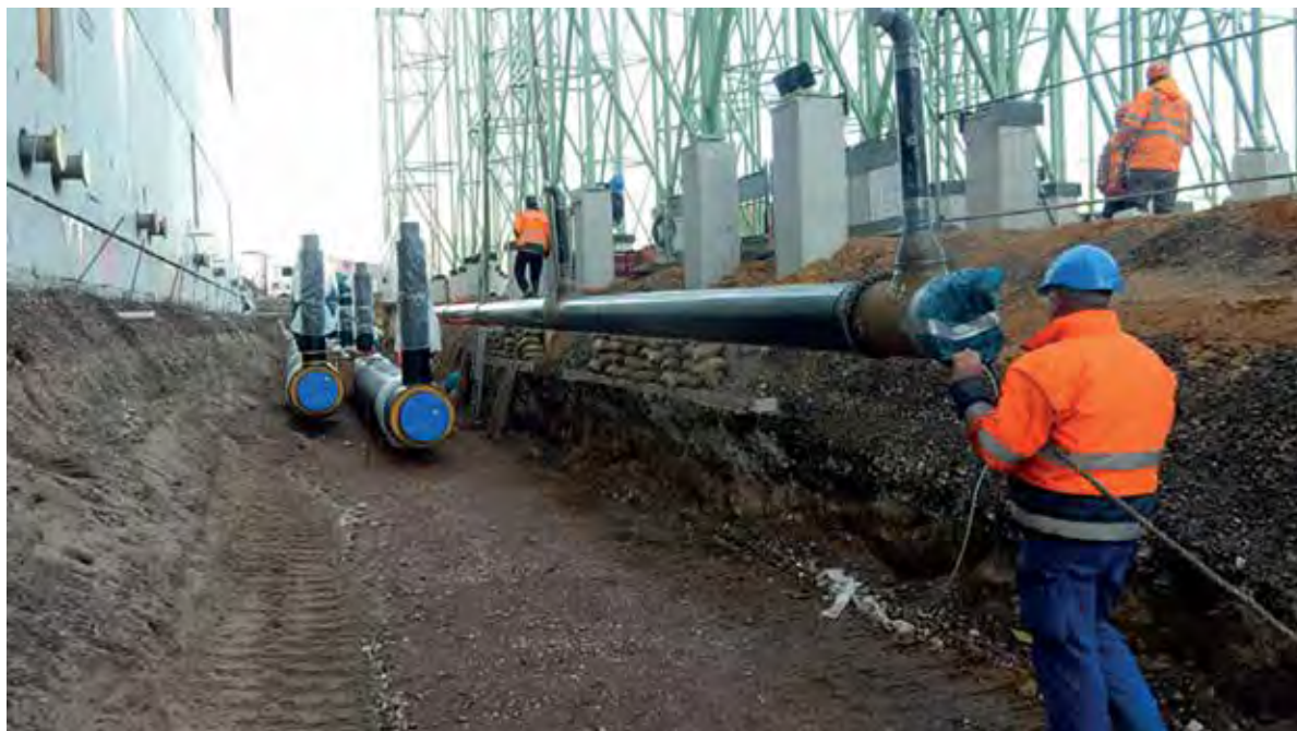
Auf der Ingelheimer Aue in Mainz wurde ein neues 100-MW-Blockheizkraftwerk errichtet, das mit seinen 10 Gasmotoren Strom und Fernwärme für das gesamte Stadtgebiet Mainz liefert. Zum Speisen der Gasmotoren mit H-Gas wurde eine Gasleitung HD DN 250 verlegt.
