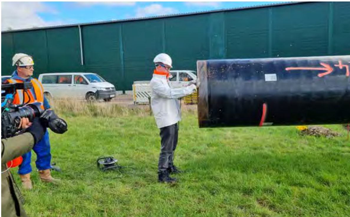
#pipeline31 – Der YouTuber tomatolix hat die Bauarbeiten an der WAL für den rbv mit der Kamera begleitet. Der Dreh an dem Prestige-projekt macht den Leitungsbau auf einzigartige Weise sichtbar.
