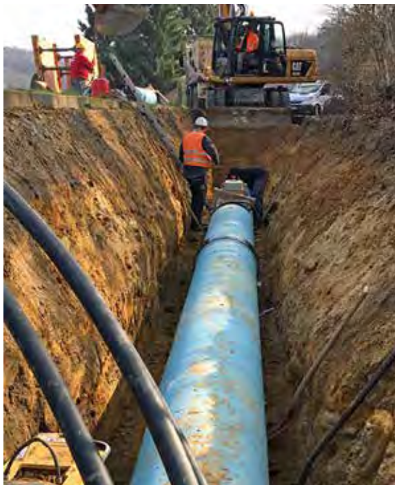
Mit dem Neubau einer Trinkwassertransportleitung hat der Wasserversorgungsverband Tecklenburger Land die Wasserversorgung in der Region dauerhaft gesichert.
