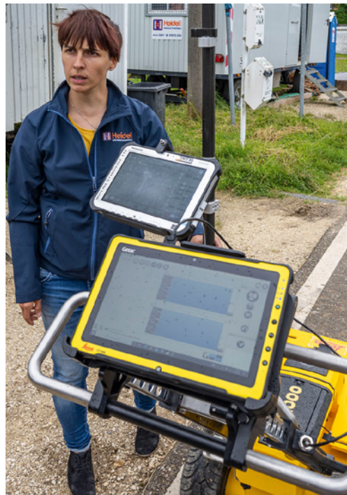
Abb. 4: Bauzeichnerin Anna Wörle ortet mit dem Bodenradar die Fremdsparten und überträgt diese in die digitale Planung.
