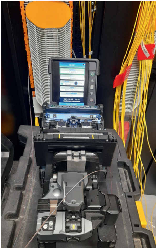
Quelle: Dähmen Rohrleitungsbau GmbH & Co. KG
