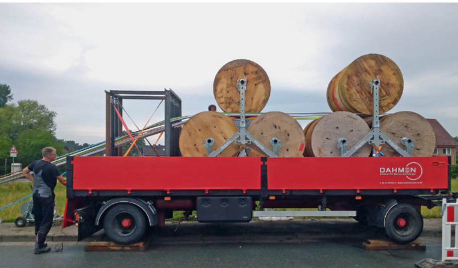
Quelle: Dahmen Rohrleitungsbau GmbH & Co. KG
